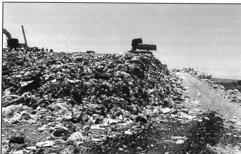
Imagen IV.7- 8 Talud sin compactación ni pendiente adecuada.
